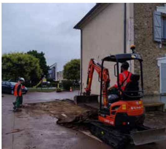
Réfection des enrobés du parking autour de la Maison des associations de la place Boécourt.
