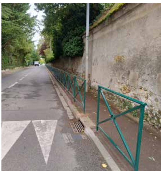
Rue de Brie, sécurisation des piétons par la pose de barrières de protection sur le trottoir reliant nos deux écoles.
