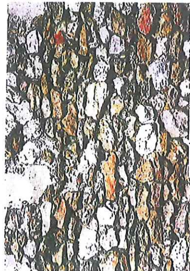
mur de moellons de meulière
